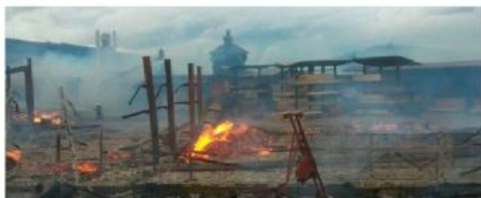
Nur mehr rauchende Trümmer blieben von der Produktionshalle und vom Bürokomplex übrig
